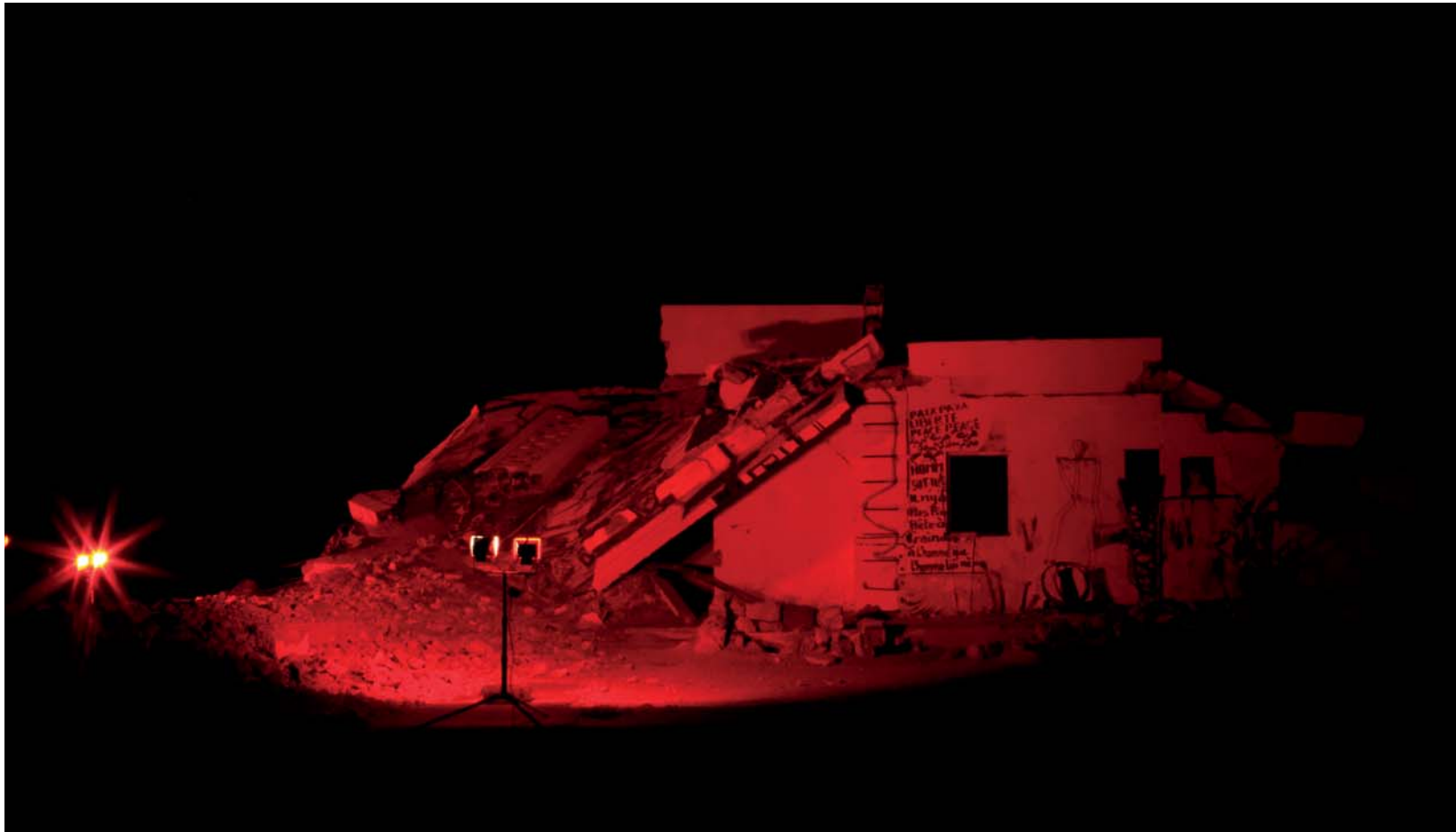
Instalación de luz. Focos rojos iluminando las ruinas de casas bombardeadas por el ejército marroquí.
